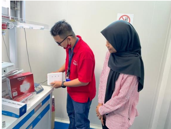
Foto No. 1 PROSES PEMASANGAN MODEM WIFI ORBIT
