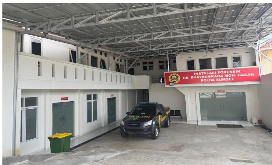
Gambar 3 Pusat Layanan Uryandokpol Yang Masih Proses Renovasi
